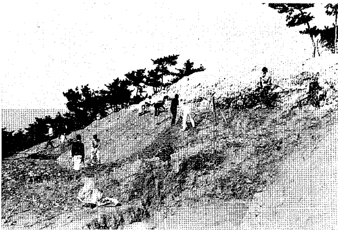
上段の清掃露出作業↓
